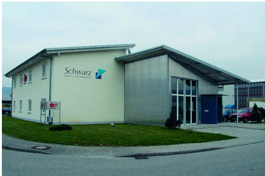
Bild 1: Das neue Firmengebäude ist schon fast wieder zu klein
